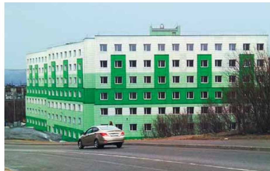
Жилой дом улице Аскольдовцев, Мурманск
