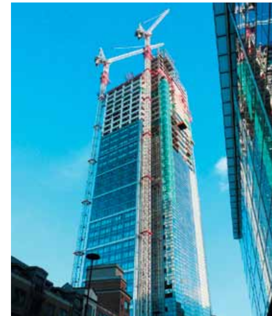
Строительство Heron Tower
