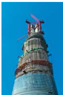
Ход монтажа наверху башни
