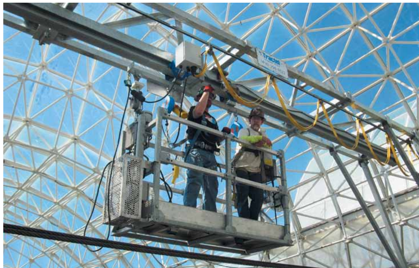
Монтаж оборудования для Biosphere 2
