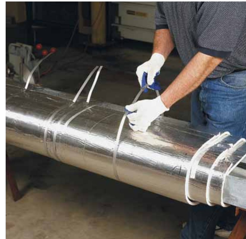
Огнезащита кабельных лотков эндотермическим материалом Interam
