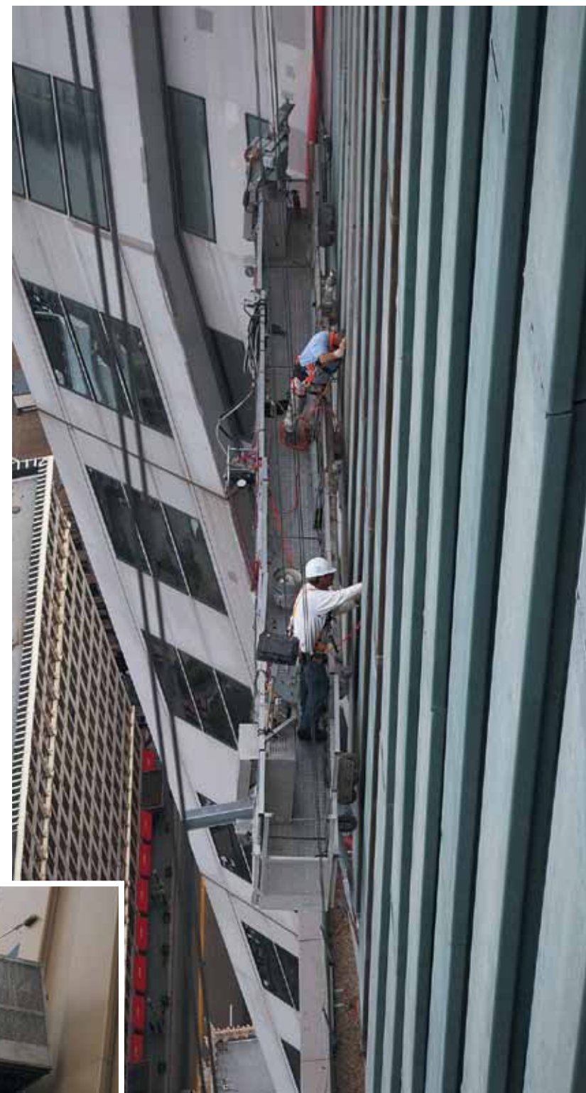
Покраска фасадов Mellon Bank Center
