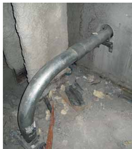
Топливопровод до монтажа огнезащитного покрытия
