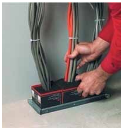
Огнезащитная кабельная гильза
