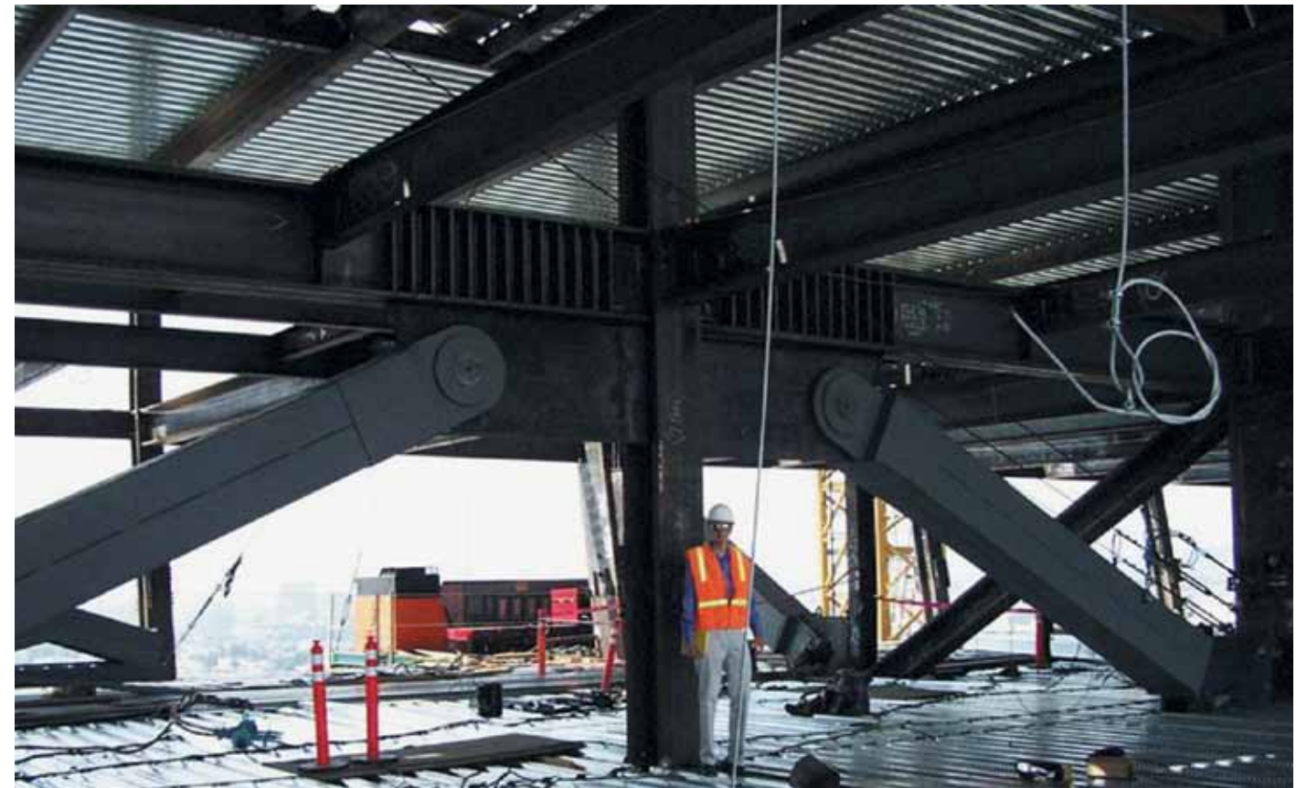
Рис. 17. L. A. Live Tower – стяжки, выдерживающие продольные изгибы (BRBs). © Nabih Youssef Associates
