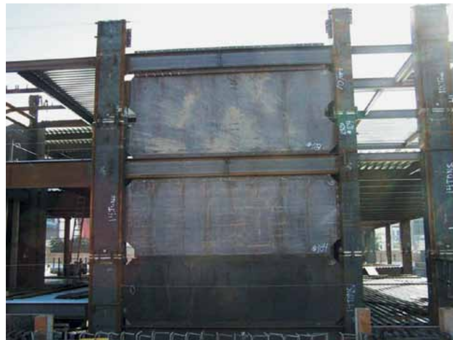
Рис. 16. L. A. Live Tower – стальные пластины стены жесткости. © Nabih Youssef Associates Design
