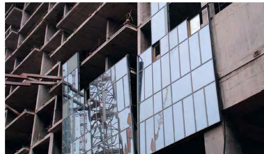
Вверху. Огневые испытания навесных панелей объекта на ул. С. Макеева, Москва Внизу. Монтаж панелей для жилого комплекса на ул. Пырьева, Москва
