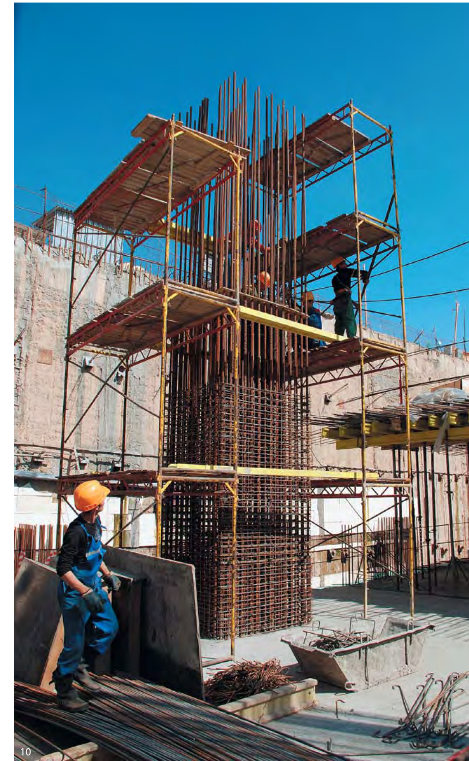
Рис. 9. Общий вид участка строительства (февраль 2009 года)
