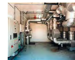
Шафы управления насосными группами СЦХ
