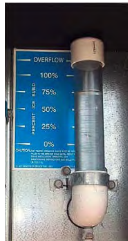
Элементы системы управления льдоаккумуляторами
