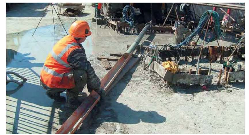
Рис. 5. Извлечение керна из колонковой трубы
