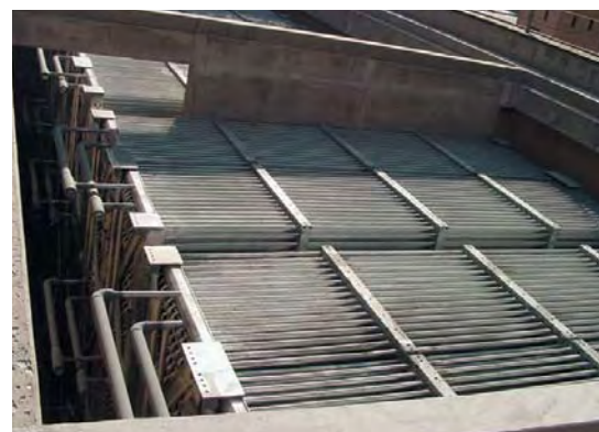
Установка теплообменников для льдоаккумулятора
