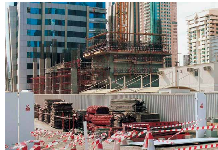
Rolex Tower: интерьер одной из зон вестибюля и начальный этап строительства
