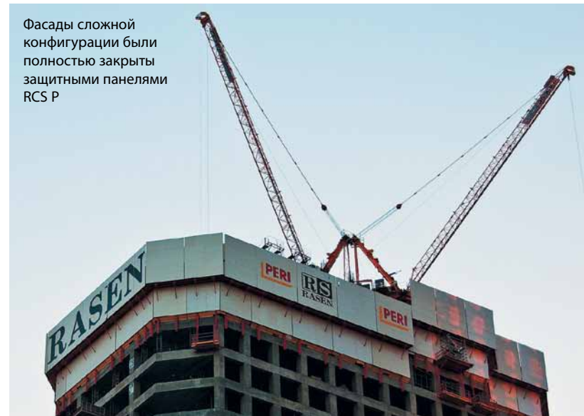
На следующую захватку система RCS P перемещалась мобильными гидравлическими агрегатами
