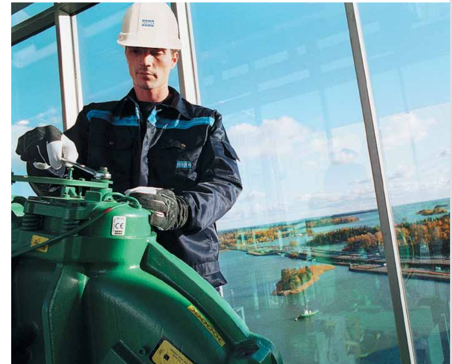
Монтаж лифтового оборудования
