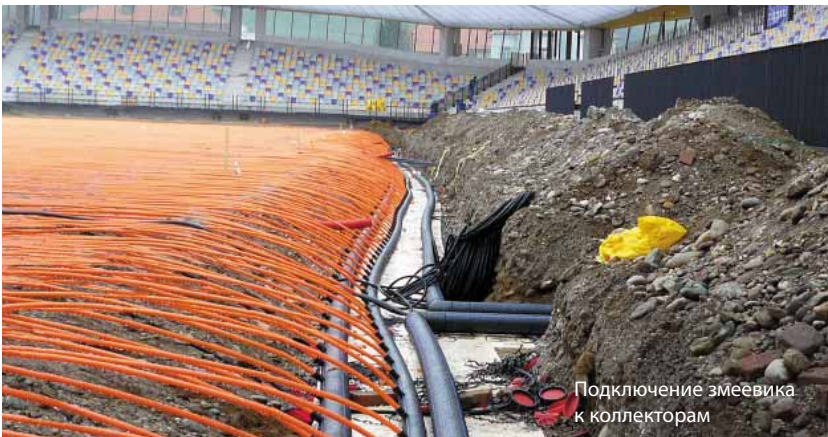
Укладка змеевика из сшитого полиэтилена
