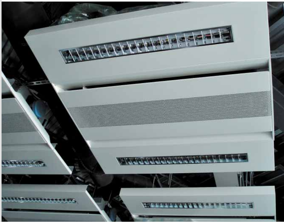
Рис. 7. Экспериментальная компактная охлаждающая балка
