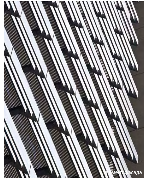
С восточной и западной сторон фасады спроектированы более узкими, что уменьшает их нагрев
