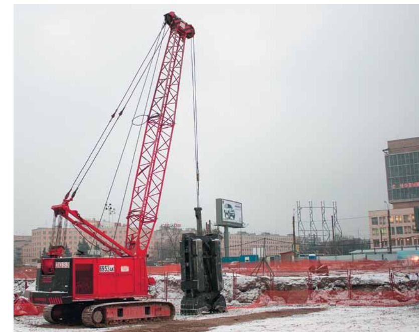
Рис. 3. Гидравлический грейфер
