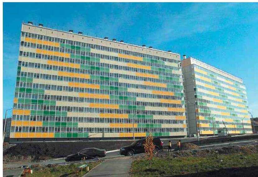
Ул. Даурская, Красноярск
