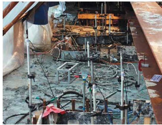
Рис. 13. Вид реперной балки и измерительного оборудования на поверхности грунта
