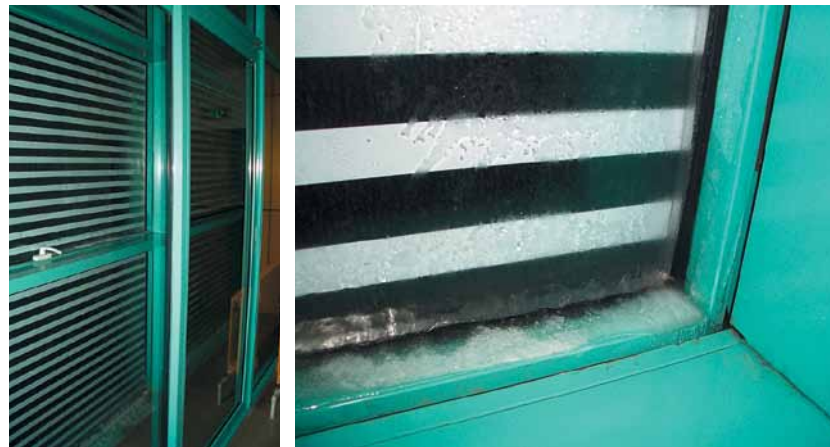
Рис. 12. Двухслойная фасадная конструкция с широкой (1500 мм) буферной зоной в натуральных условиях. Наружная температура -15°C
