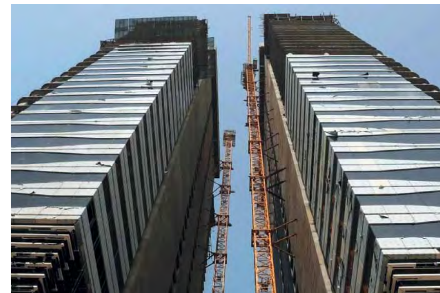
Строительство Acico Twin Towers
