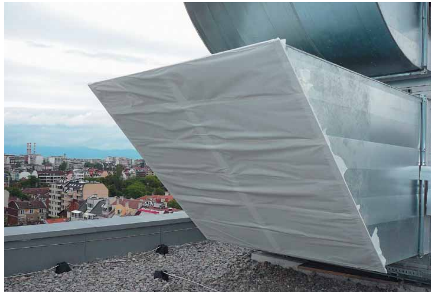
Герметизация системы вентиляции для проведения теста
