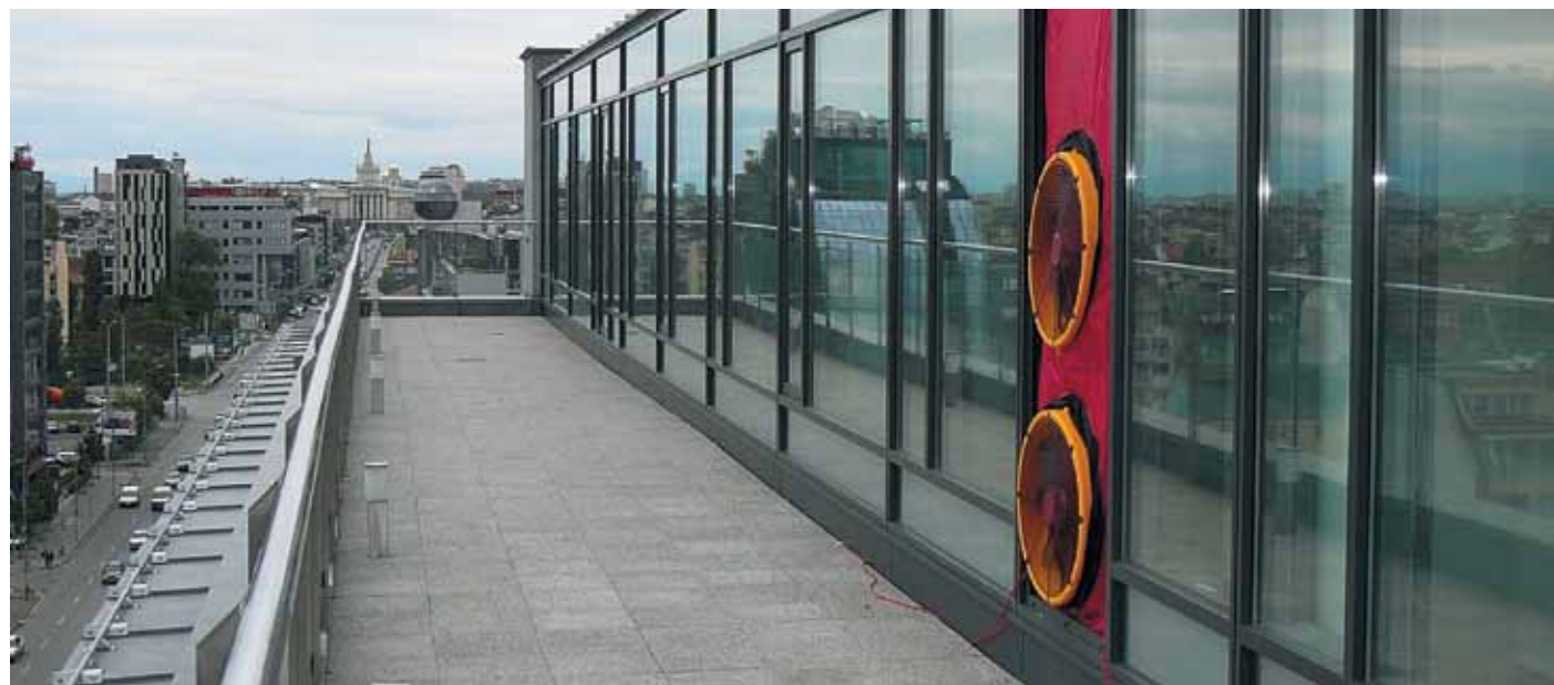
Дополнительная система РЕТРОТЕК из 2-х вентиляторов (вид снаружи)
