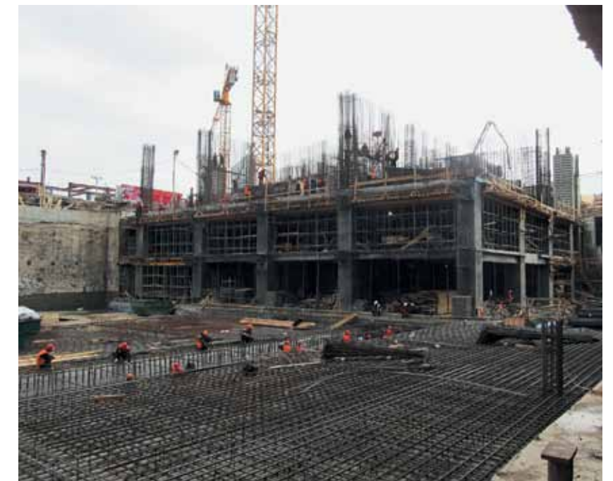
Рис. 14. Свайное поле (а) и строительство конструкций (б) 85-этажного здания
