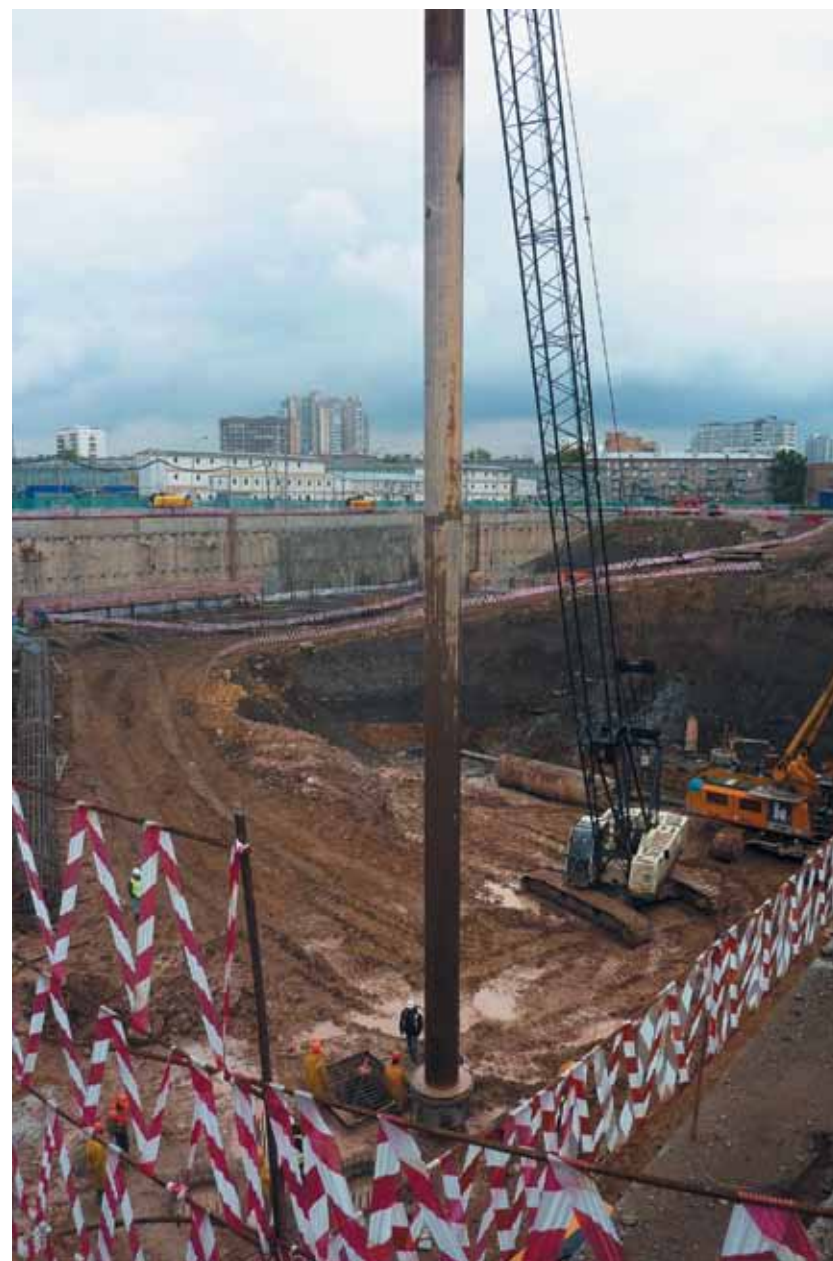
Рис. 20. Погружение центральной части внешнего армокаркаса в отдельных испытаниях сваи
