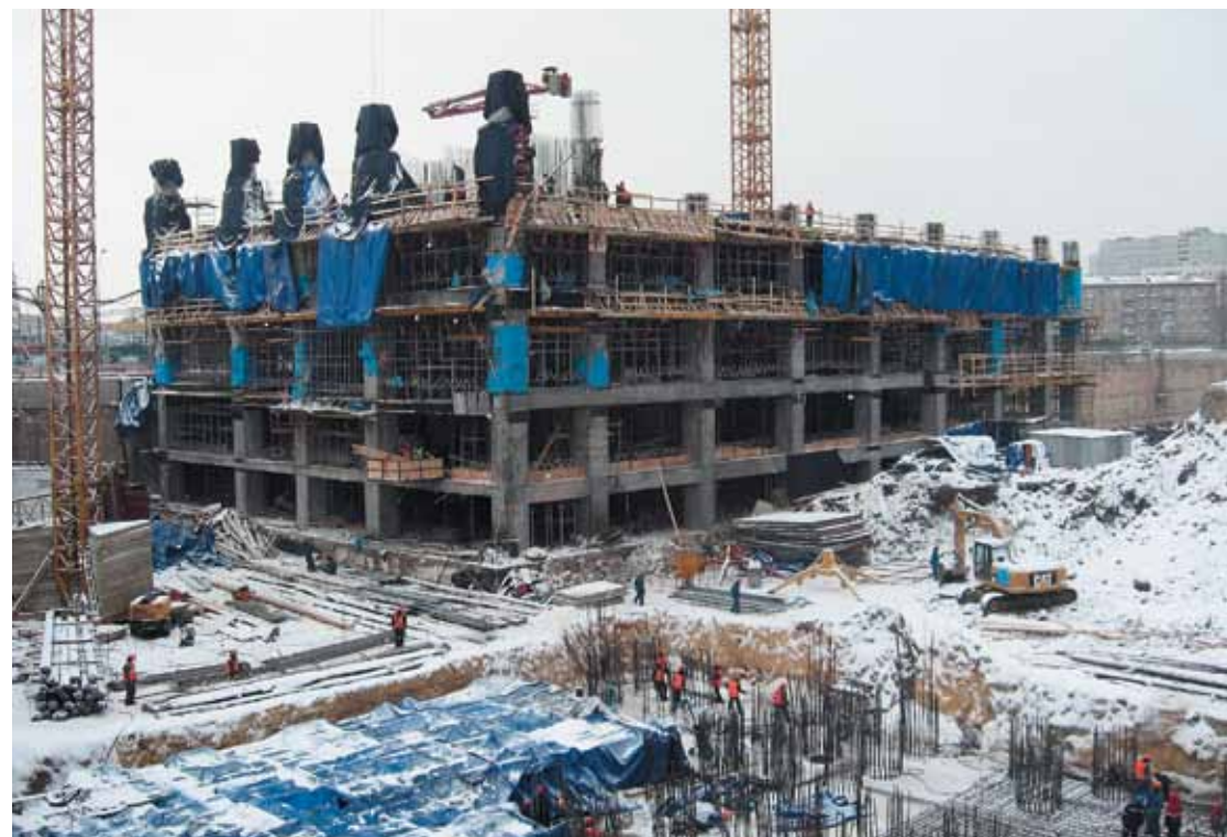
Рис. 13. Устройство свайного основания (а) и конструкций (б) 49-этажного здания
