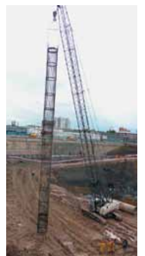
Рис. 21. Погружение внешнего армокаркаса в отдельных испытаниях сваи Рис. 22. Подготовка стенда для отдельных испытаний сваи
