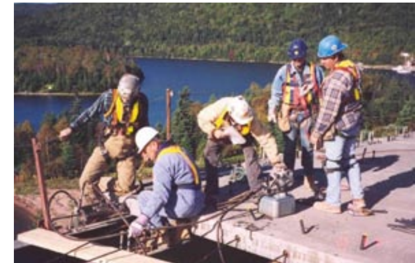
Напряжение арматурных тросов имеющих сцепление с бетоном
