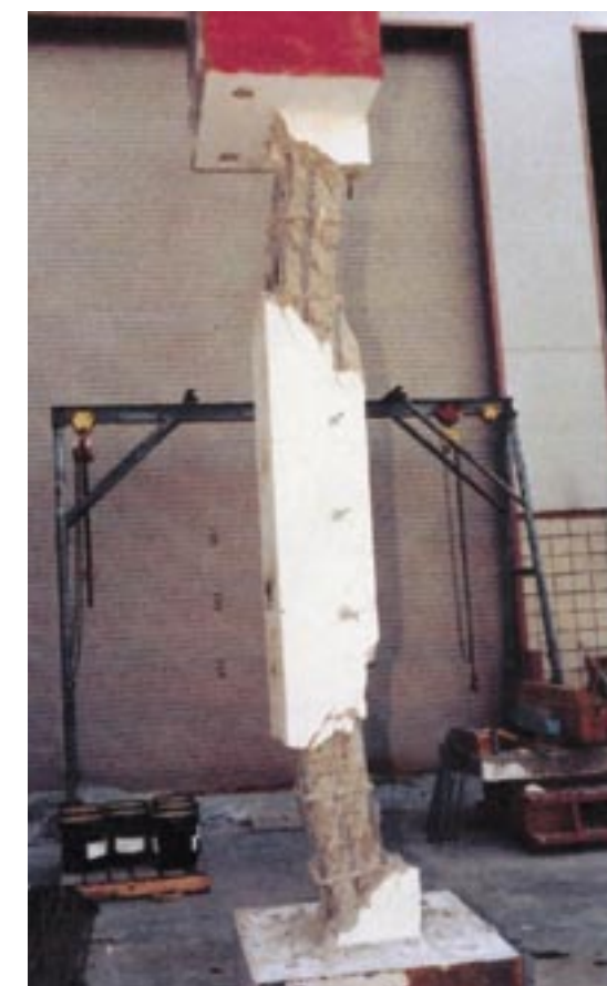
Рис. 3. Колонна без усиления после испытаний в лаборатории
