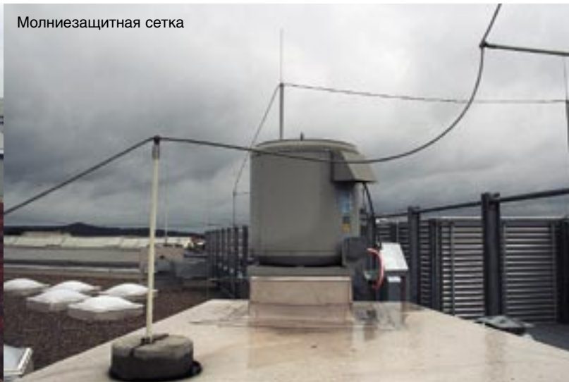
Молниезащитная сетка, защита систем кондиционирования воздуха
