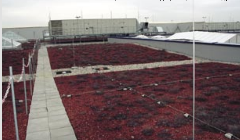
Молниезащитная сетка, защита систем кондиционирования воздуха
