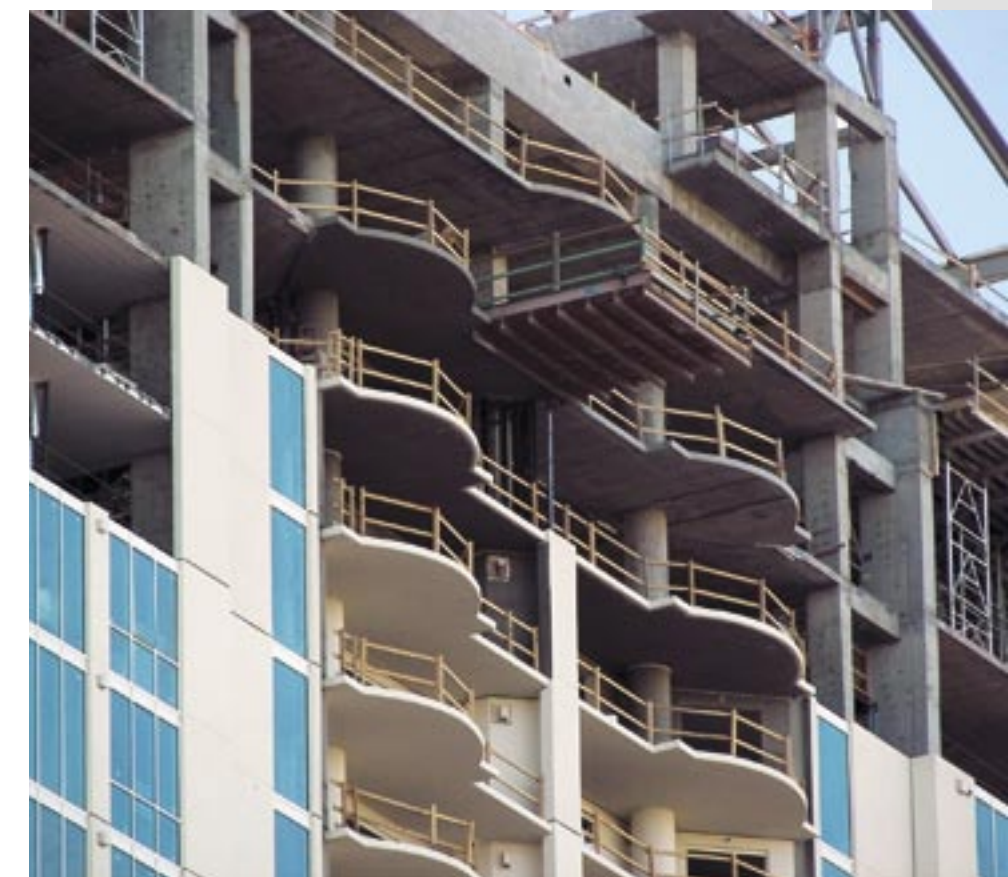
Пример использования системы безбалочных перекрытий
