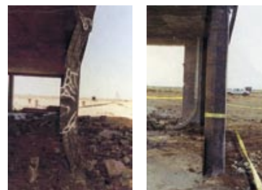
а) колонна, не усиленная б) колонна, усиленная углепластиком
