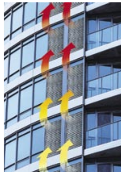
Рис. 5. Потоки горячего воздуха от блоков систем кондиционирования, расположенных друг над другом
