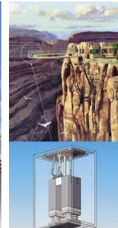
Система контроля инерционных колебаний моста Grand Canyon Skywalk
