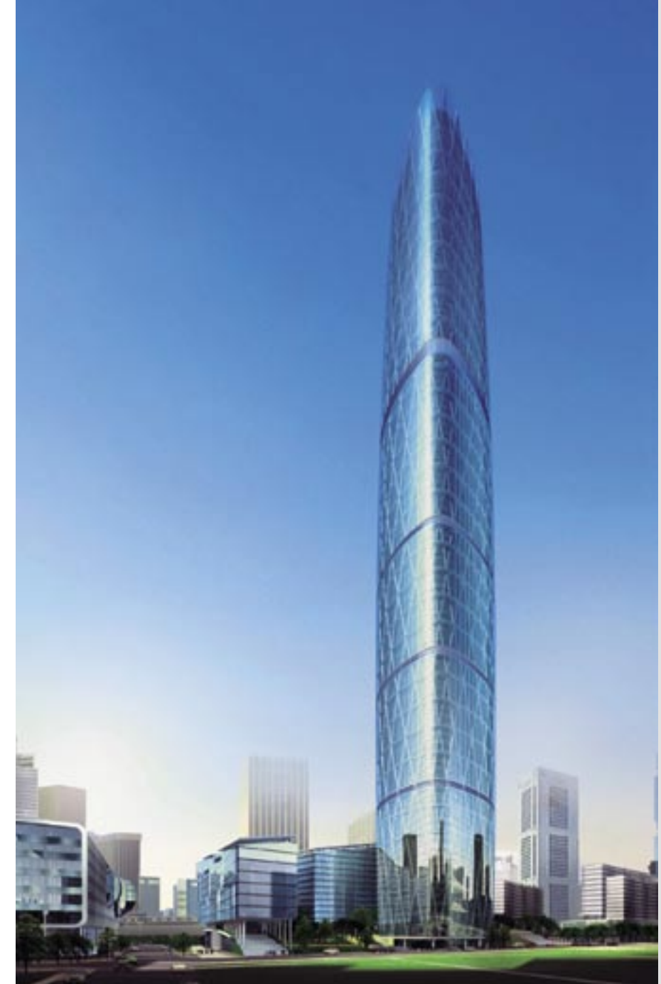
Общий вид башни «Гуанчжоу»
