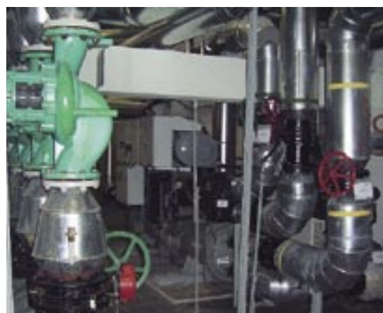
Хладоцентр, оснащенный чиллерами Carrier 30HXC
