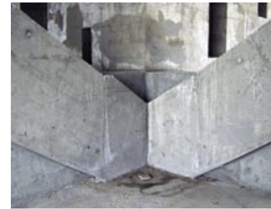
Рис. 7. Узел сопряжения стен центрального ядра и наклонных аутригеров на техническом 18-м этаже башни «Санкт-Петербург» а – армокаркас, б – готовая конструкция
