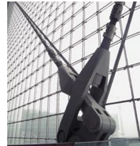
Фрагмент крепления фасадных конструкций
