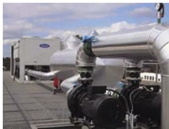
Крыша с установленными чиллерами Carrier 30GX
