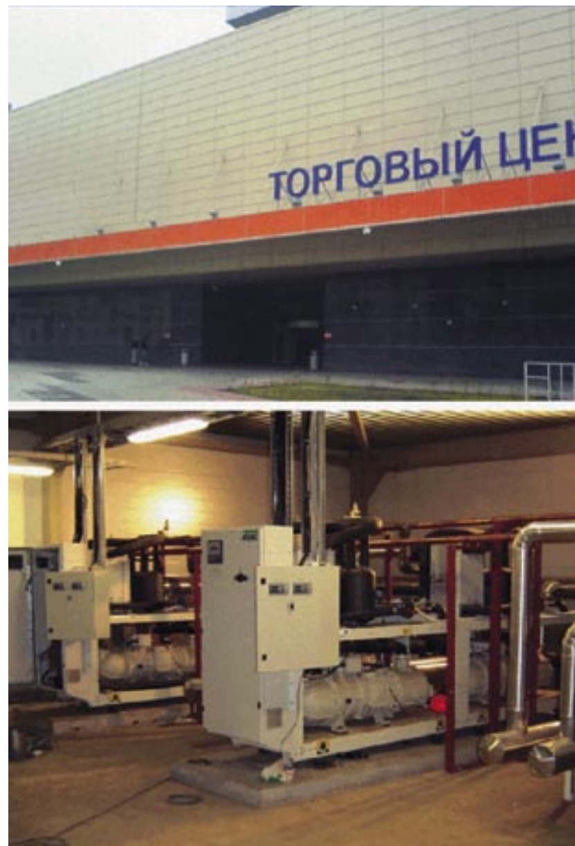
Торговый комплекс, оснащенный чиллерами
