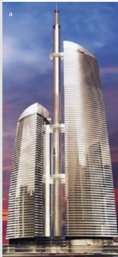
Рис. 3. Комплекс «Федерация» а) макет б) каркас одной из башен в стадии строительства
