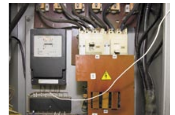
Приборы, установленные в электросети
