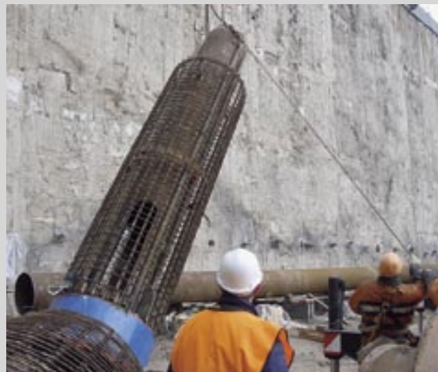
Опускание нижней части комплексного модуля
