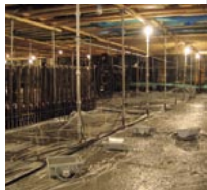
Рис. 6. Выпуск арматуры с конической резьбой
