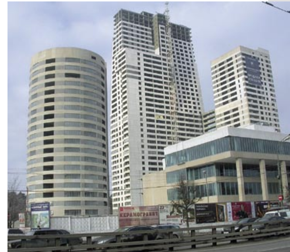
Рис. 2. Здания жилого комплекса «Северный парк»
