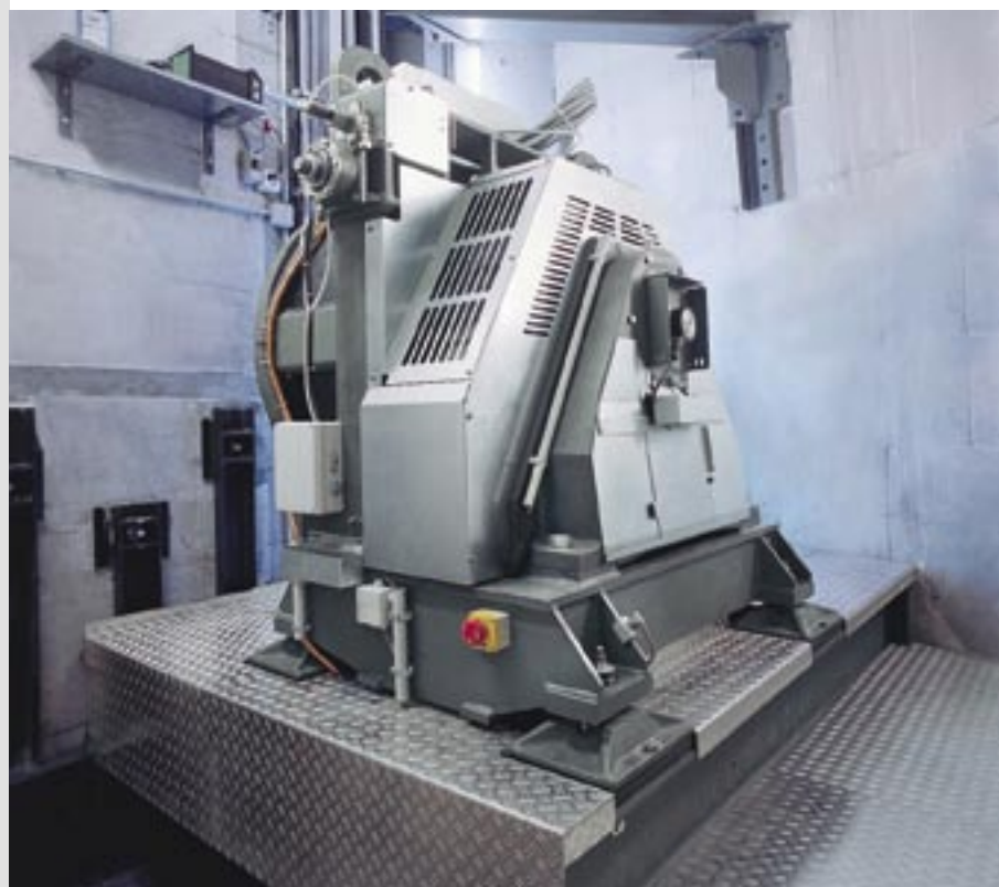
Привод скоростного лифта Schindler 7000
