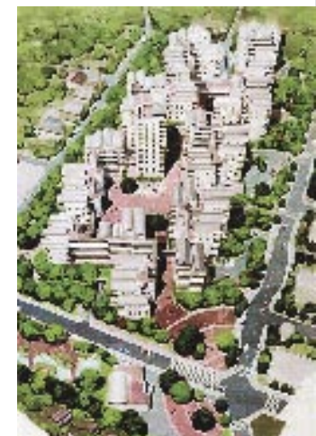
Рис. 6. Огромная сейсмоизолированная искусственная площадка 12,349 кв. м, Сагамихара. Изолирующие устройства расположены на вершине колонн
