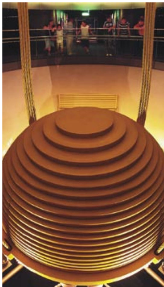
Схема расположения и внешний вид демпфера в здании «Тайбей»
