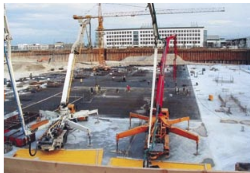
Глубокий котлован при строительстве многофункционального комплекса в Мюнхене (Германия)
