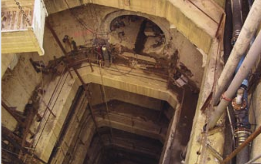
Глубокий котлован и микротоннели для выполнения струйной цементации при строительстве станции метрополитена на линии Север – Юг в Кельне (Германия)
