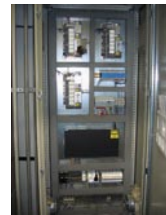
Вид щита контроллеров централи BMS
