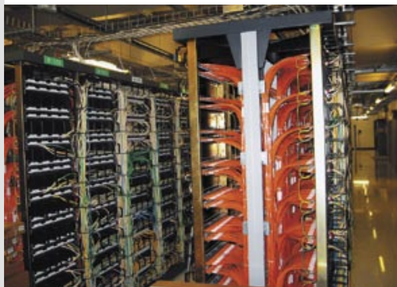
Центральная кроссовая в процессе монтажа
