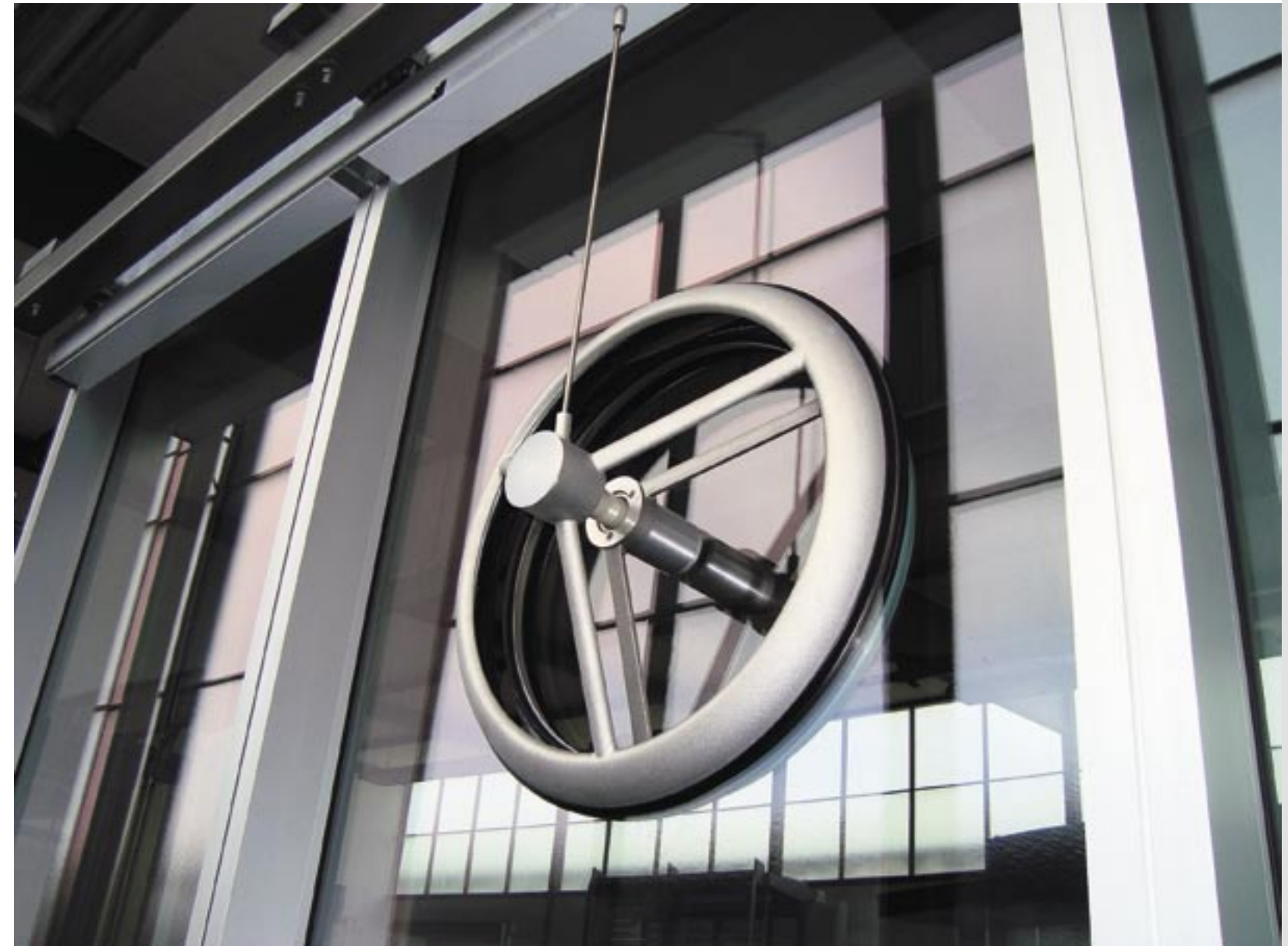
Фасадная конструкция компании «Гартнер» с системой вентиляции
