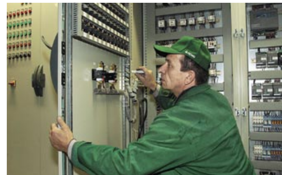
Монтаж щита автоматики
