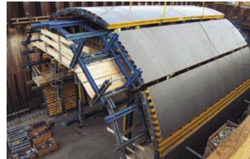
Участок H2-2 Radfeld Mitte-тоннель
