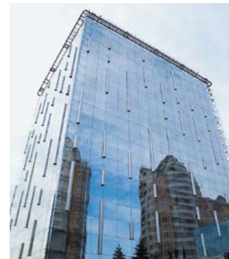
Офисное здание, ул. Ефремова, 10 Двойной фасад, наружная нитка фасада – планарное (спайдерное) остекление
