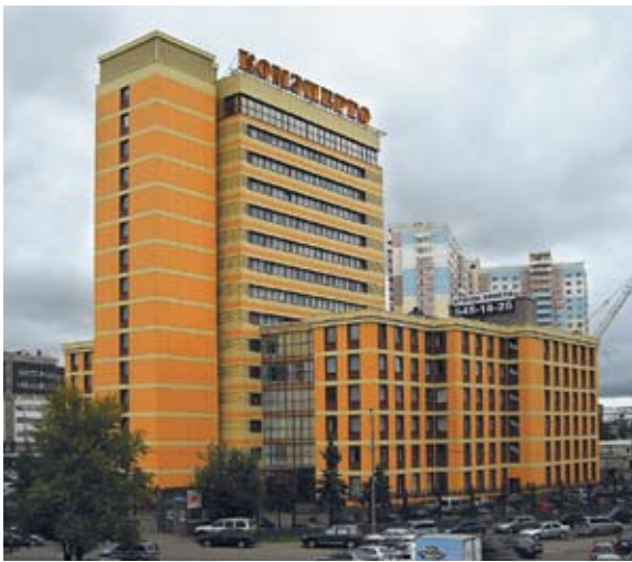
Бизнес-центр, Москва. Высота – 75 м. Облицовка – композитные алюминиевые панели
