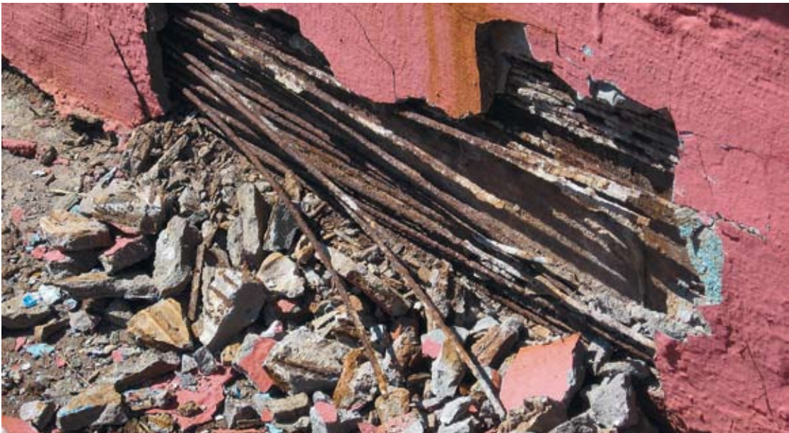
Разрушение предварительно напряженной арматуры вследствие карбонизации защитного слоя
