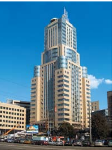
Бизнес-центр «Сахаров Плаза», Москва. Высота – 130 м. Облицовка – объемная керамика «Фаветон»
