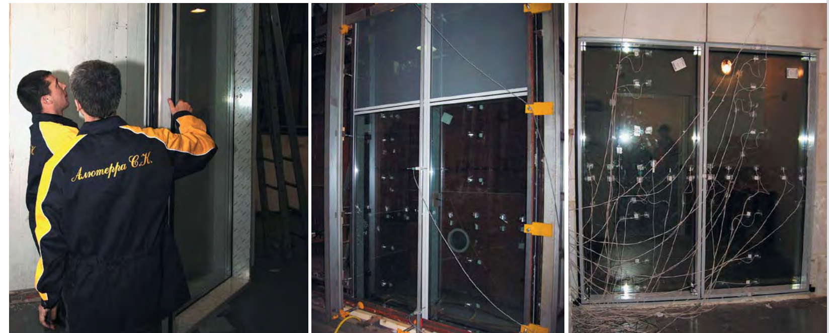
Монтаж фасадной конструкции в климатической камере НИИСФ РААСН
