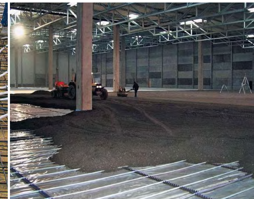
Укладка змеевика напольного охлаждения
