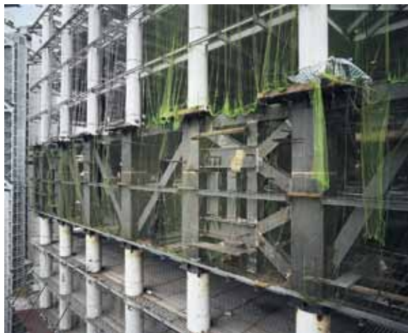
Рис. 45. Cheung Kong Center, внешний вид аутригеров и пояса ферм. © Arup
