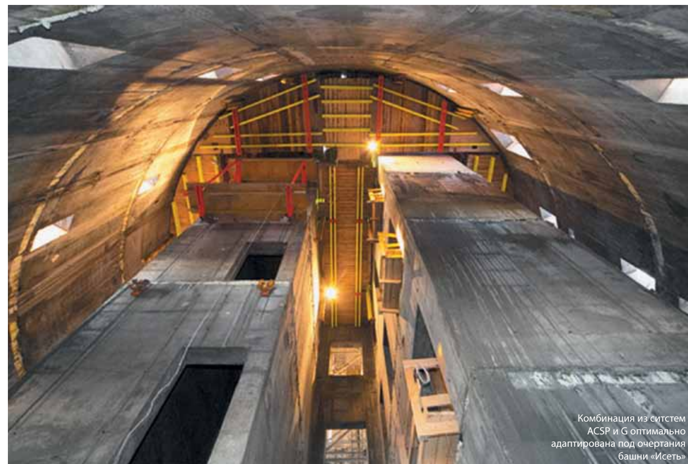
С системой RCS наружная опалубка круглых стен ядра безопасно поднимается по направляющим этаж за этажом
