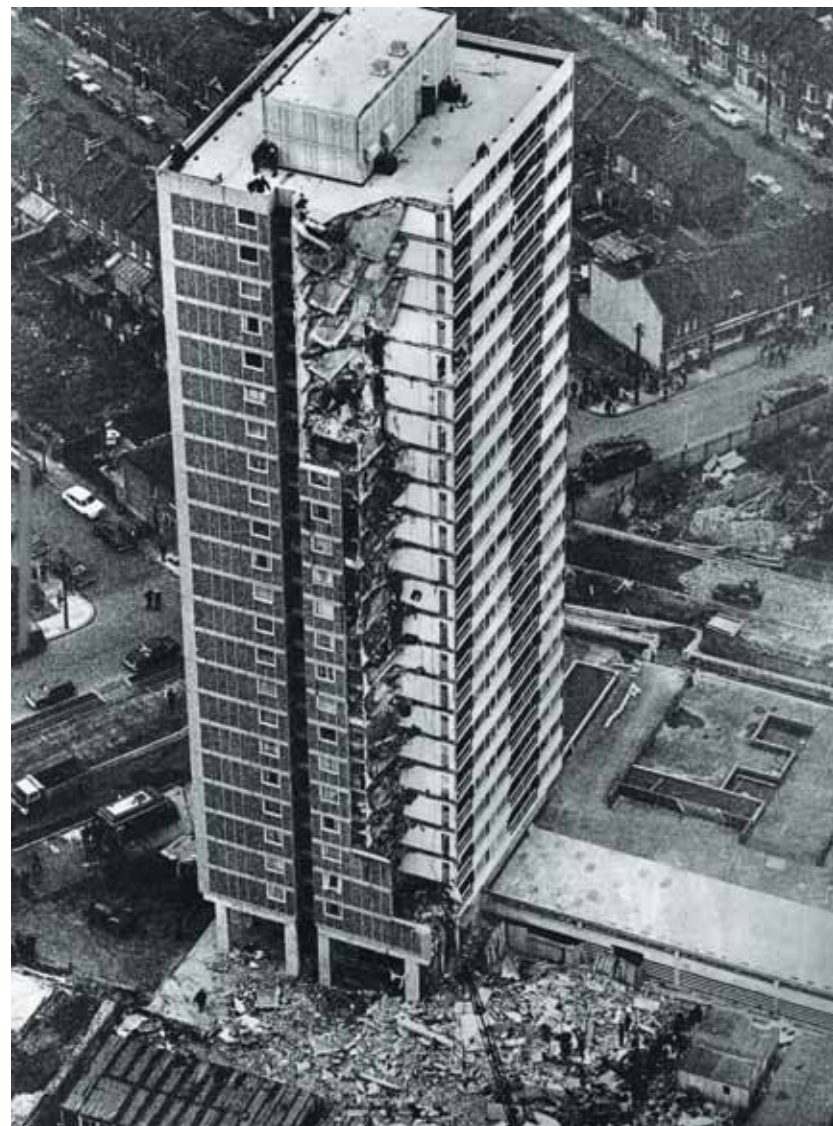
Рис. 1. Прогрессирующее обрушение секции 22-этажного жилого панельного дома Ronan Point в Лондоне (1968)
