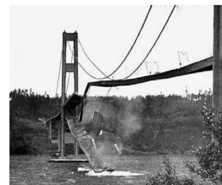
Рисунок 1. Обрушение Такомакского моста (США) 7.10.1940 г. Последствия в результате возникновения аэродинамической неустойчивости – изгибно-крутильного флаттера
