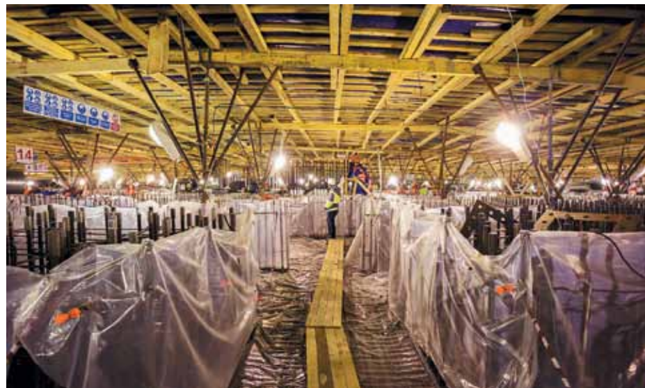
Теплоизолирующее покрытие регулирует скорость остывания бетона
