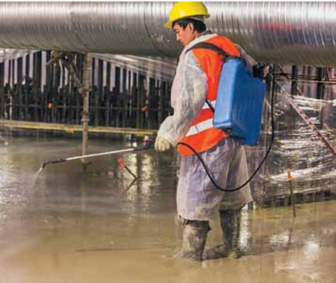
Увлажнение забетонированного участка
