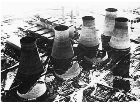
Рисунок 4. Разрушение градиен под действием ветрового потока Рисунок 5. Макеты однотипных сооружений в рабочей части аэродинамической трубы
