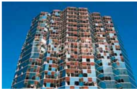
Рис. 1 Разрушения фасадных конструкций при ветровой нагрузке
