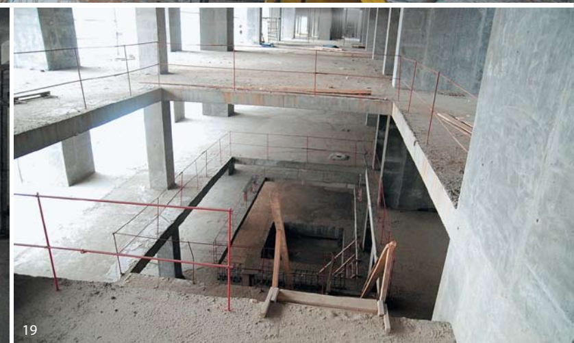
Рис. 17. Выполнение работ в зоне примыкания к «стене в грунте»
