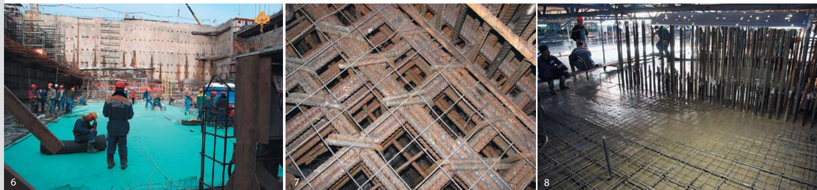
Рис. 8. Бетонирование 6-ой захватки фундаментной плиты
