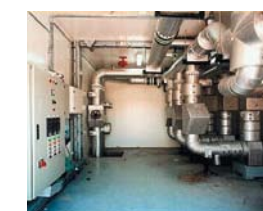
Шафы управления насосными группами СЦХ
