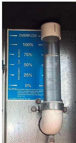
Элементы системы управления льдоаккумуляторами
