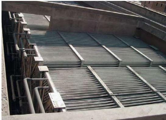
Установка теплообменников для льдоаккумулятора
