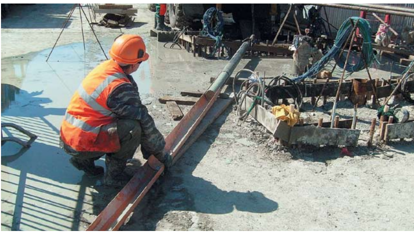
Рис. 5. Извлечение керна из колонковой трубы
