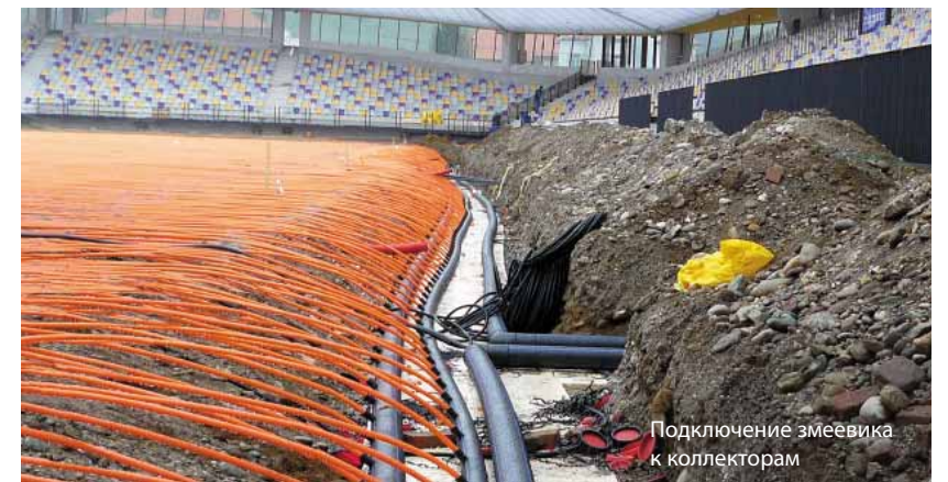
Укладка змеевика из сшитого полиэтилена
