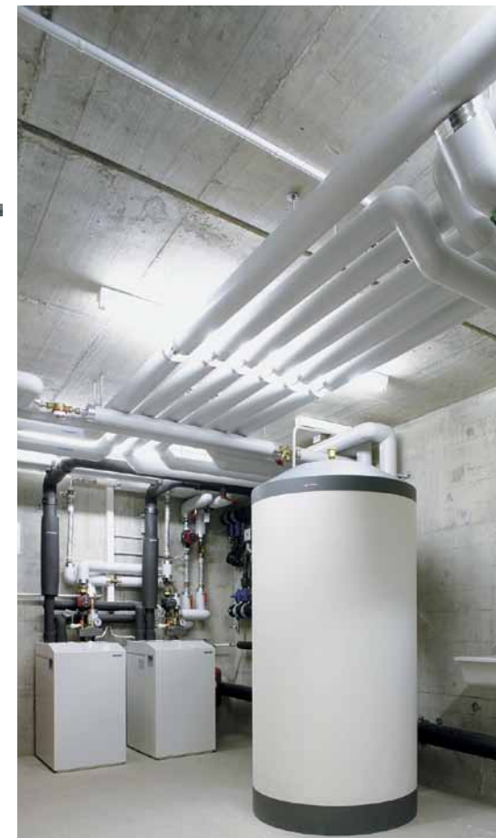
Тепловой насос системы «Грунт-Вода» компании Stiebel Eltron серии WPF
