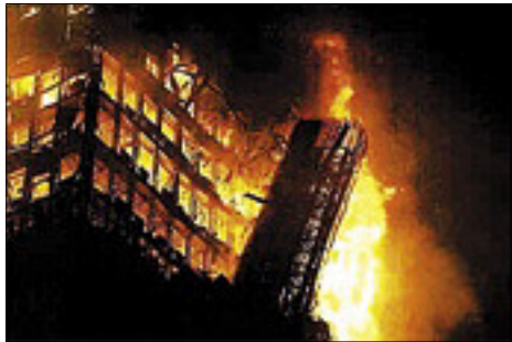
Рис. 2. Последствия пожара навесной фасадной системы
