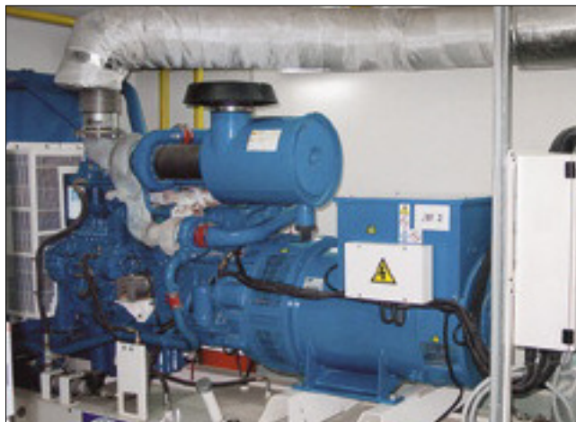
Дизель-генераторная установка
