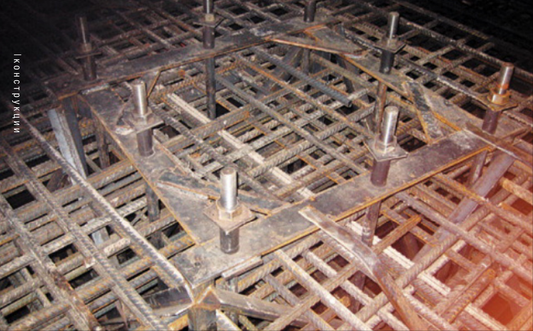
Узел металлокаркаса плиты фундамента башни
