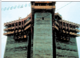
Строительство бетонного ствола
