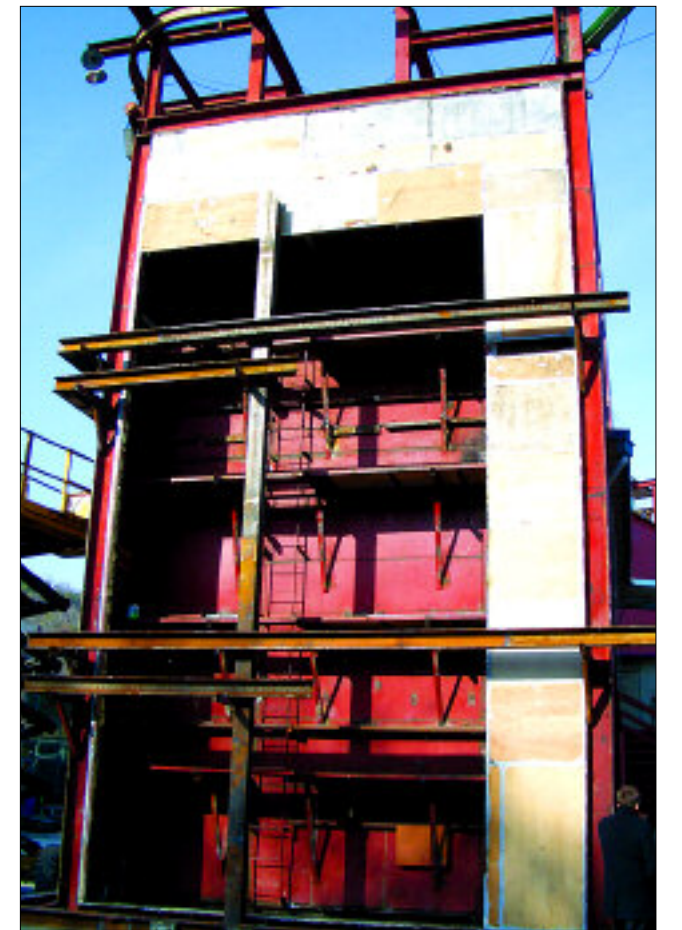
Процесс строительства климатической камеры
