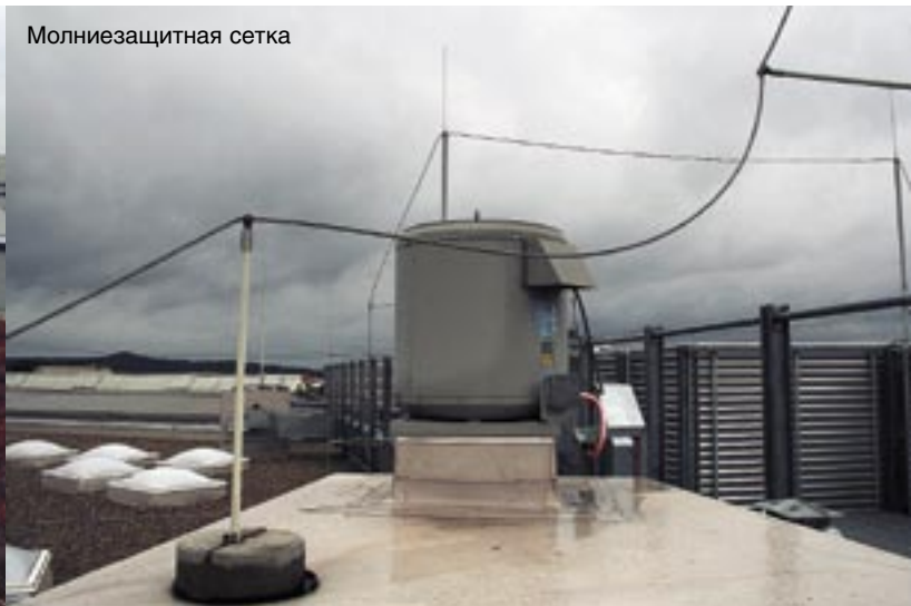
Молниезащитная сетка, защита систем кондиционирования воздуха
