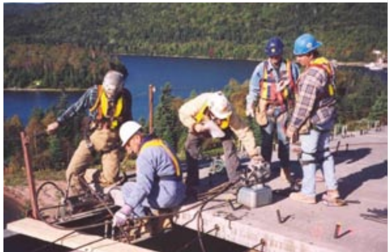
Напряжение арматурных тросов имеющих сцепление с бетоном
