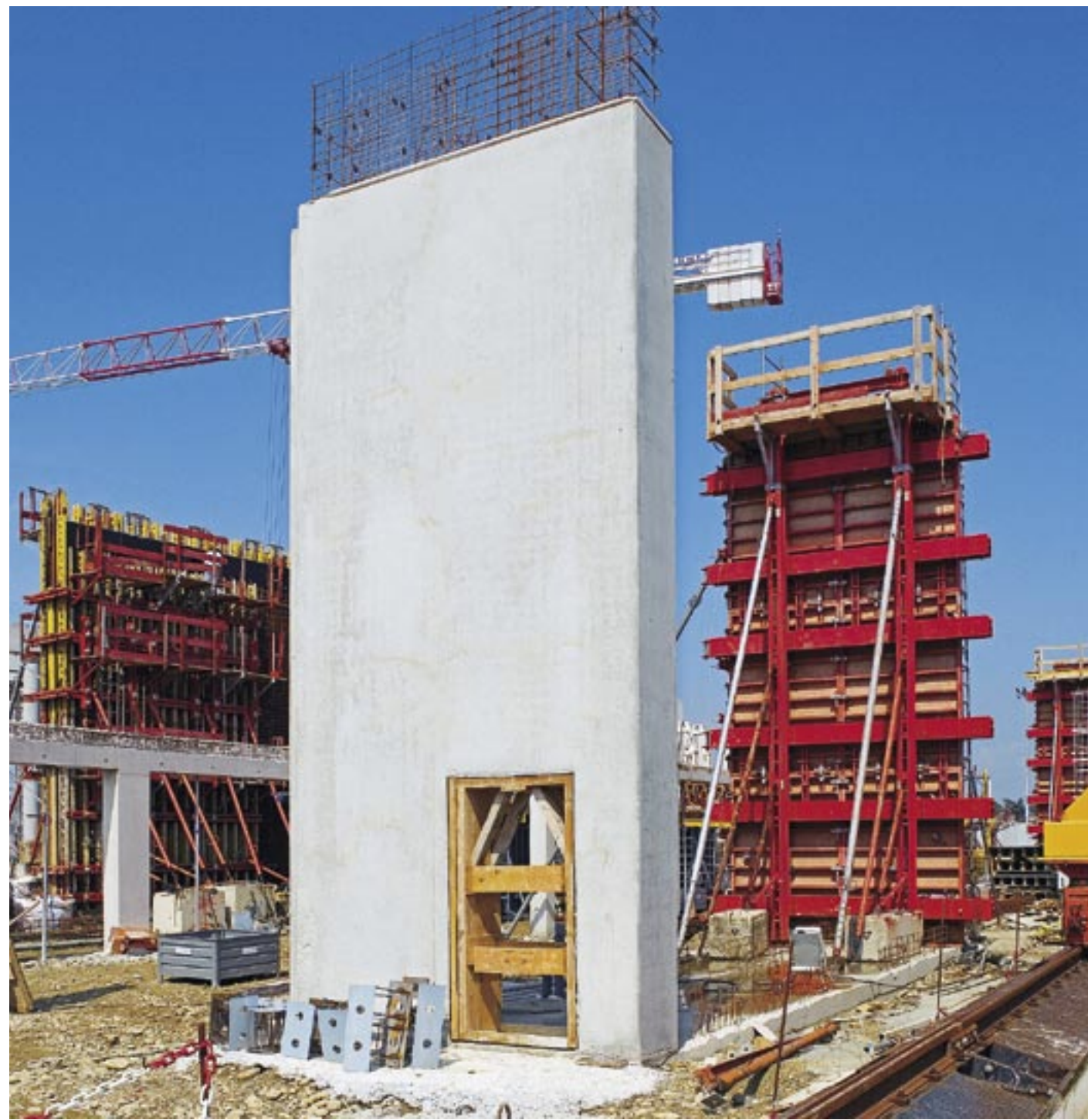
Система PERI RCS, аэропорт Тулузы, Франция
