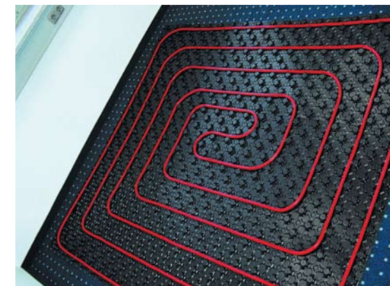
Монтаж напольного охлаждения
