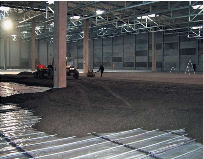
Укладка змеевика напольного охлаждения
