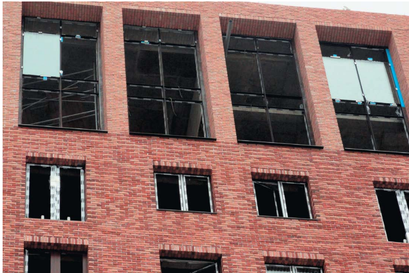
Облицовка колонн, горизонтальных поверхностей, перемычек, гладь стены
