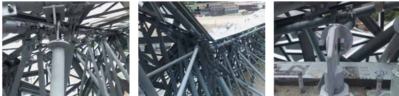
Монтаж узлов обложки архитектурно-художественного оформления порталов совмещенной дороги Адлер – «Альпика-Сервис»
