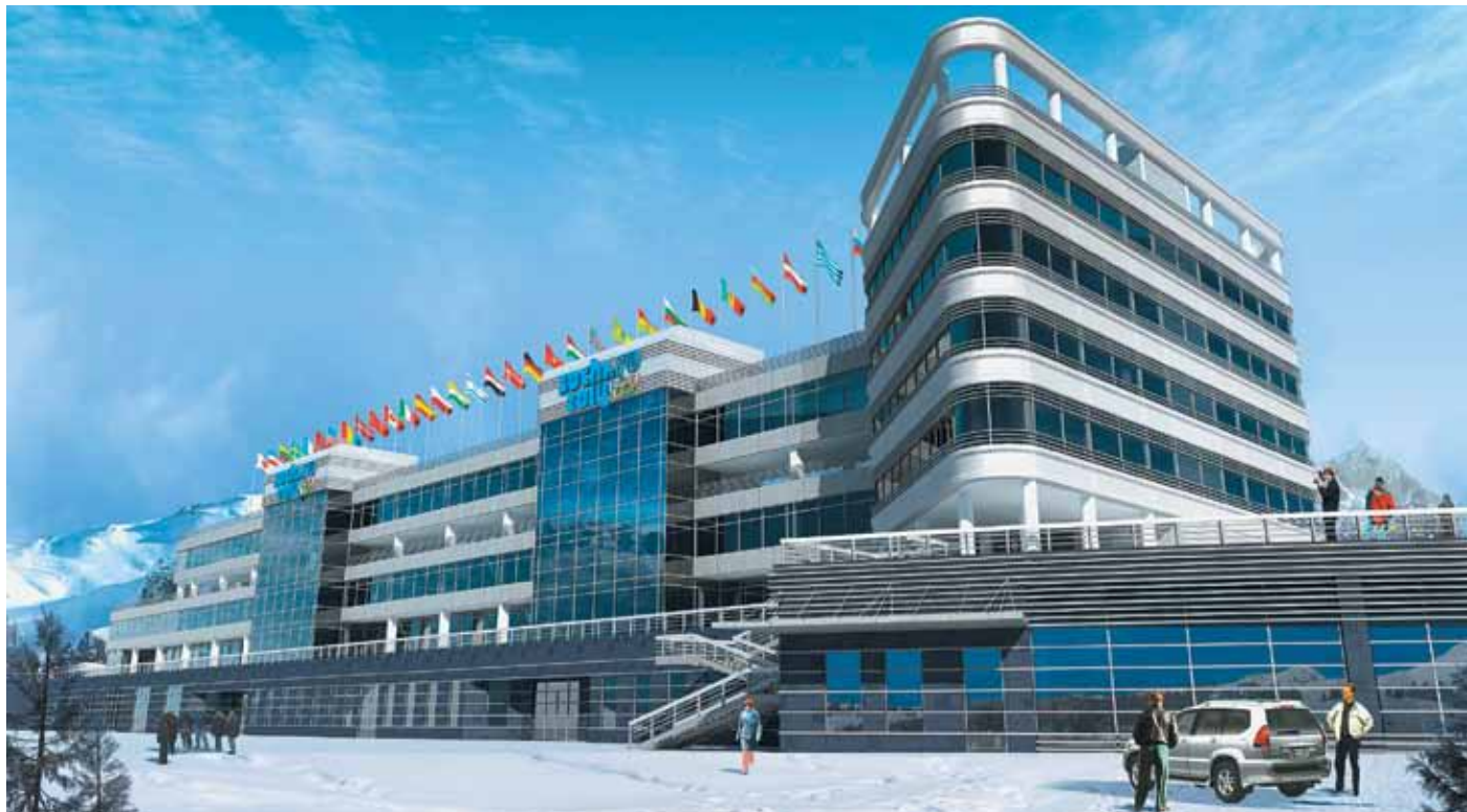
Лыжно-биатлонный комплекс «Лаура», Сочи
