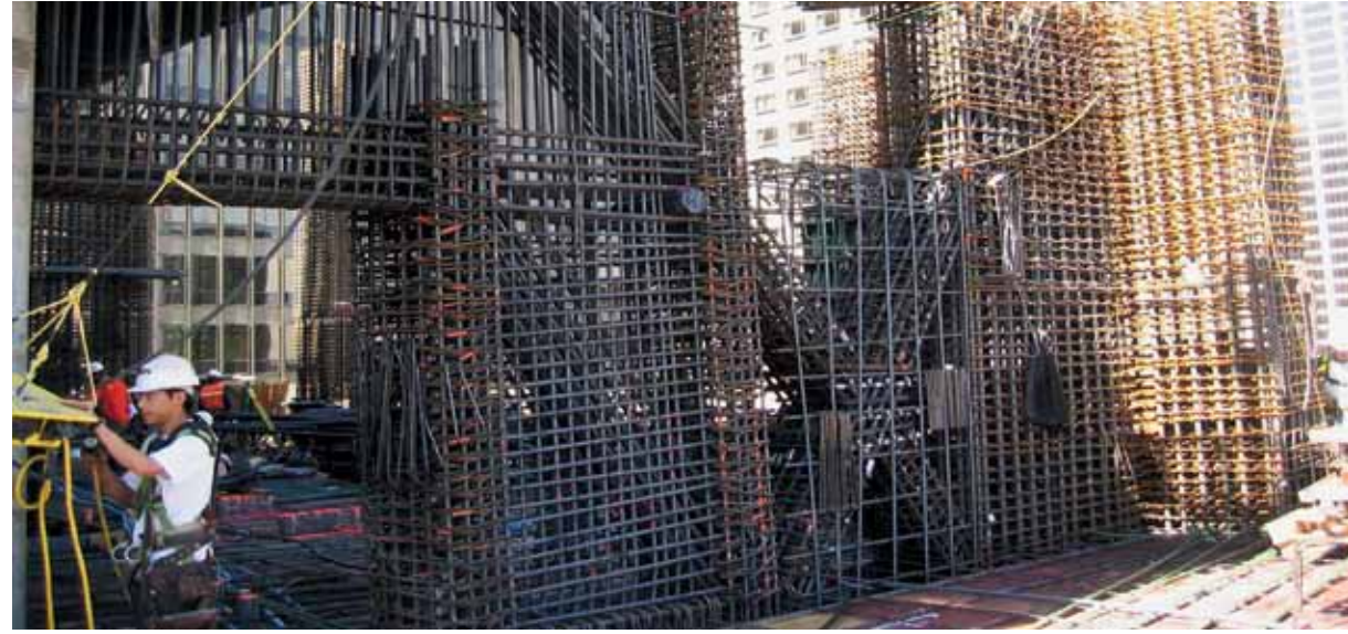
Рис. 31. Millennium Tower, ядро-аутригерная система. © DeSimone Consulting Engineers
